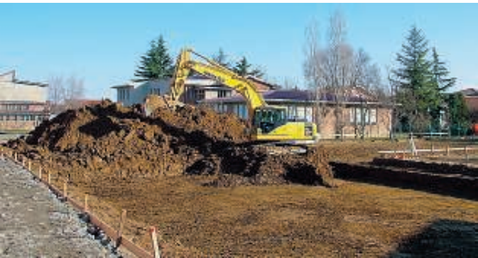
Pronto entro il 2010 Ruspe al lavoro per il nuovo asilo.
